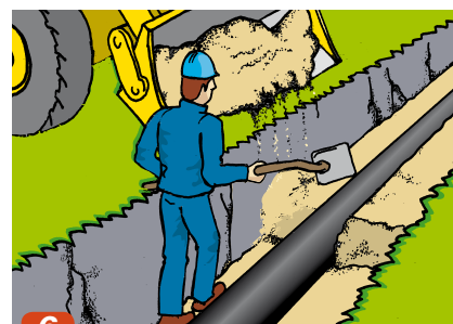
6 Kringfyllningen skall fyllas jämnt på båda sidor om röret.
